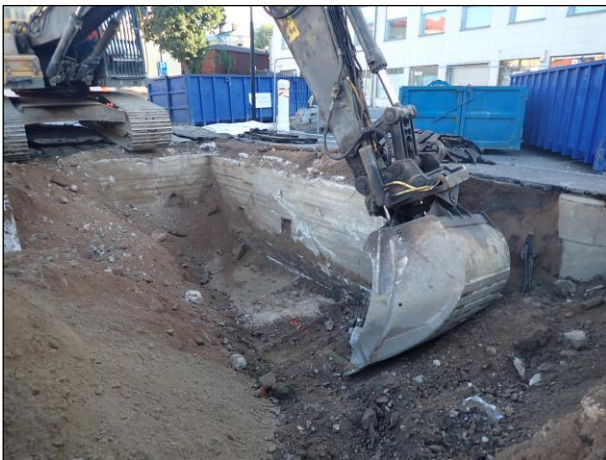
Vasemmalla: Betonisokkeliä puretaan kaivannon itäreunassa. Kuvattu koilliseen. Oikealla: Sokkelin takana, kaivurajan seinämässä, näkyy murskeita ja muovirakenteita.
