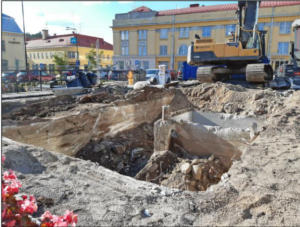
Vasemmalla: Betonisokkeli luoteeseen kuvattuna. Oikealla: Kaivun etelärajan seinämässä näkyy todennäköisesti kioskin rappusiin liittyvää betonirakennetta.
