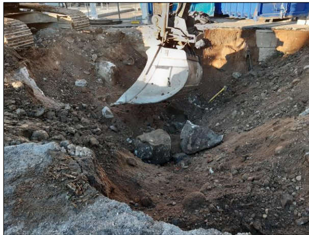
Vasemmalla: Täyttömaasta tulleita lohkareita. Oikealla: Kaivanto valvonnan päättyessä. Kaikkea kaivettua maata ei viety pois, vaan sitä liikuteltiin ja tasattiin kaivantoon. Kuvattu kaakkoon.
