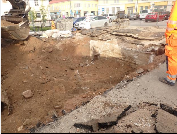
Vasemmalla: Sokkelin pohjoissivu ennen poistoaan (vas.) ja poiston jälkeen (oik.). Kaivurajan seinämässä on sorahiekkaa eli täyttömaata.
