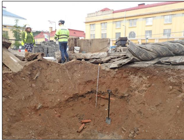
Vasemmalla: Valmiin kaivannon luoteiskulmassa on pohjaan asti täyttömaata ja keraamista putkea. Mitta 155 cm. Oikealla: Kaivannon täyttömaasta löytynyt laastinen tiili.
