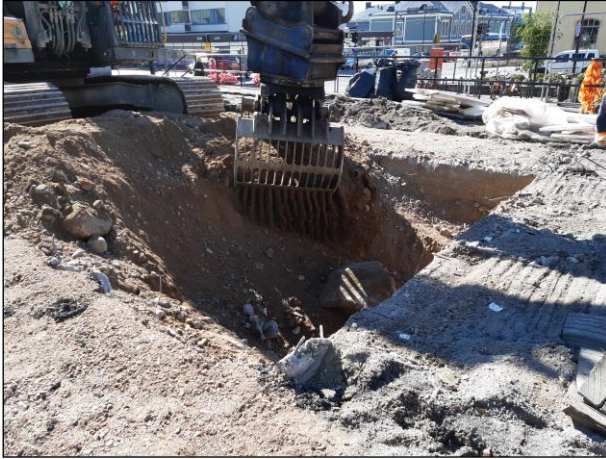
Vasemmalla: Täyttömaita kaivetaan pois betonisokkelin sisältä. Kuvattu lounaaseen. Oikealla: Betonisokkeli esille kaivettuna. Kukkapenkin reuna on kaivun eteläraja. Se sijaitsee suunnilleen samalla kohtaa, kuin kioskin entiset rappuset, joiden eteläpuolella on havaittu muinaisjäännöskerroksia vuonna 2017 (Pesonen & Koivisto 2018)
