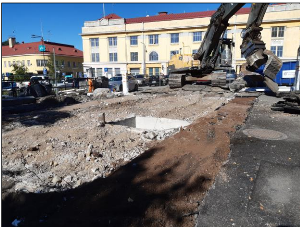
Vasemmalla: Asfaltti ja kioskin maanpäälliset osat poistettuna kaivannon alalta. Kuvattu luoteeseen. Oikealla: Edellisen kuvan keskellä näkyvä kioskin kellarirakenne.
